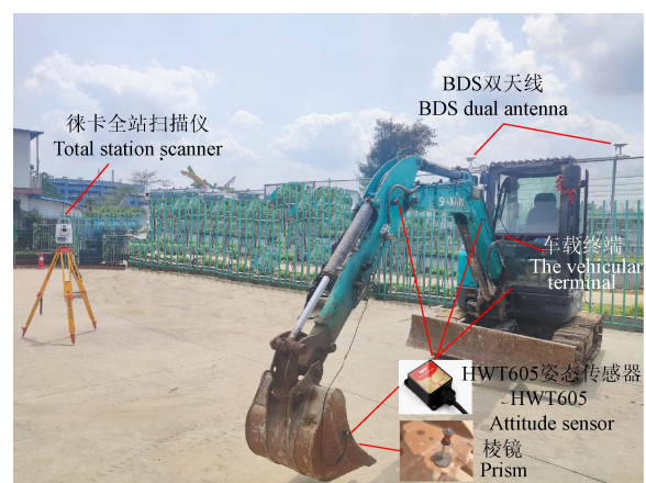
图 5 挖掘机动作试验现场图
